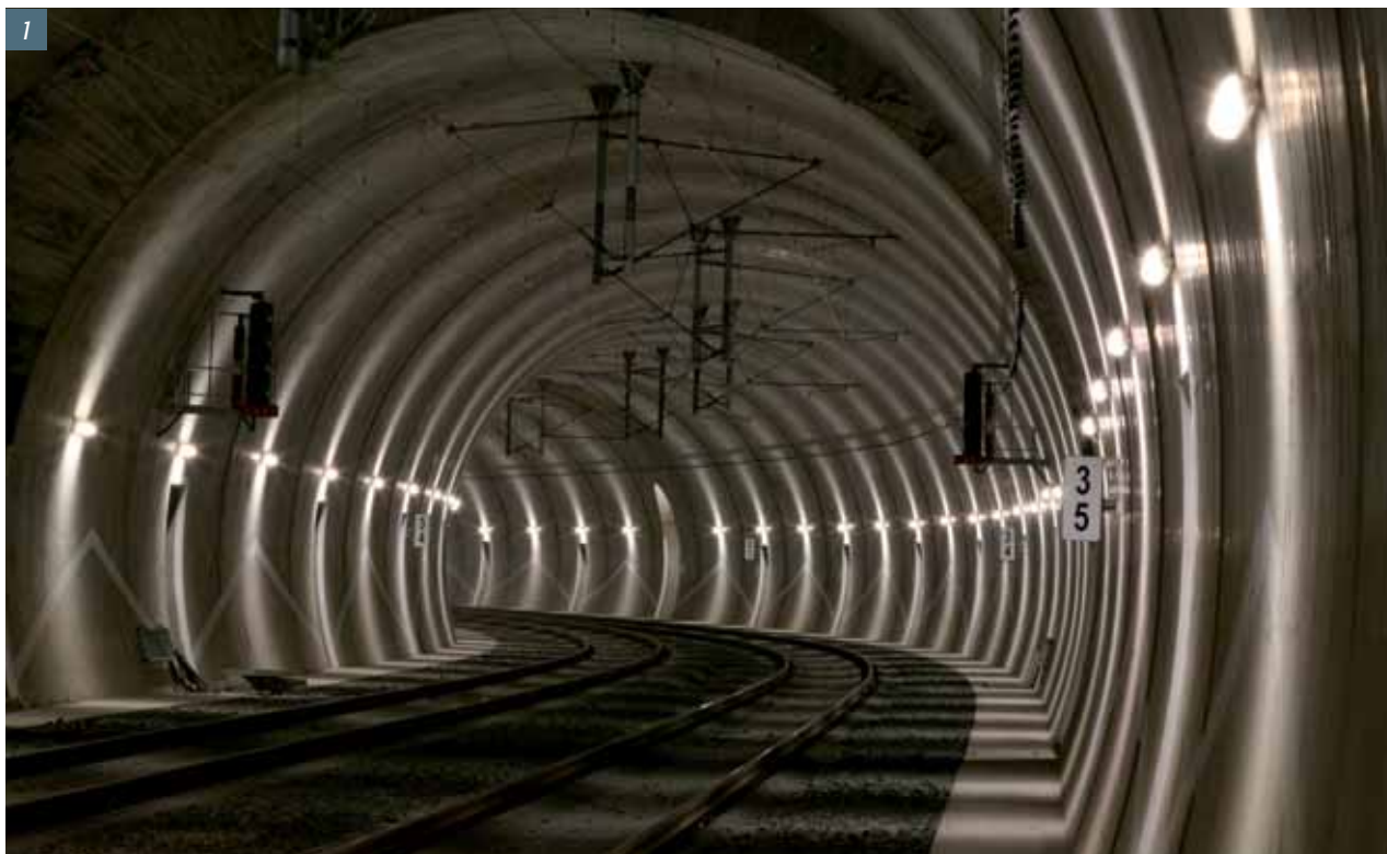
Fig. 1 Two-rail railway tunnel Nové spojení, Prague
