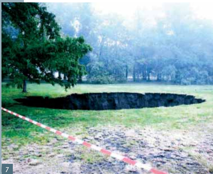
Obr. 7 Tunel Blanka – první propad nadloží v květnu 2008 Fig. 7 Tunnel Blanka – first inbreak of the overburden in May 2008
