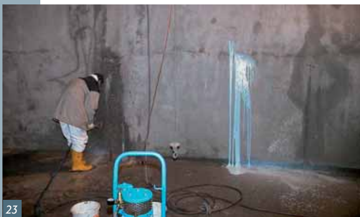
Obr. 23 Injektáž do přilehlé základové půdy se zpětným výtokem pryskyřice z jedné trhliny
