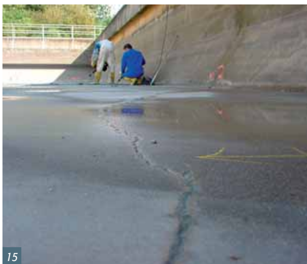
Obr. 15 Vodopropustné dělicí trhliny v podkladním betonu na ČOV (foto KST)
