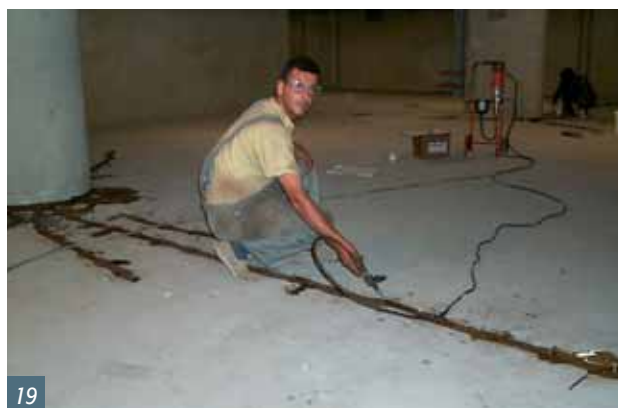
Obr. 18 Trhliny v podkladní betonové desce podzemních garáží
