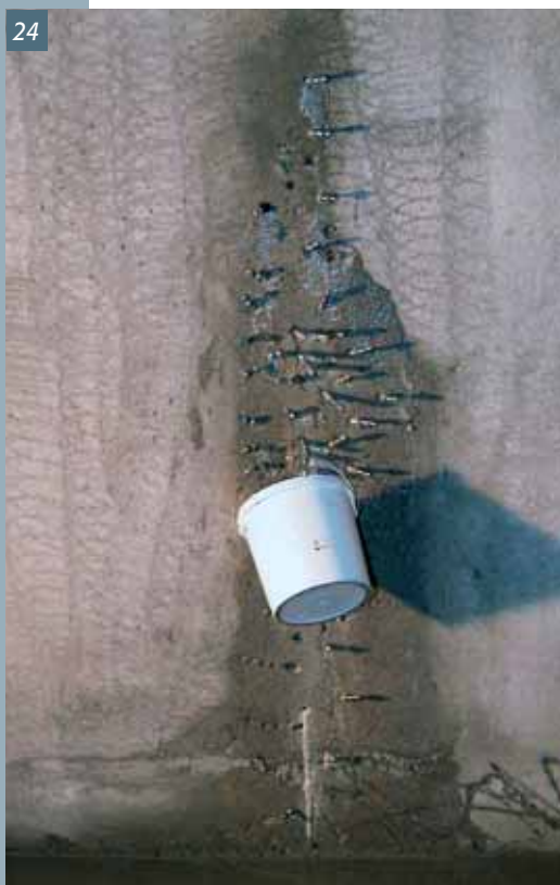
Obr. 23 Injektáž do přilehlé základové půdy se zpětným výtokem pryskyřice z jedné trhliny
