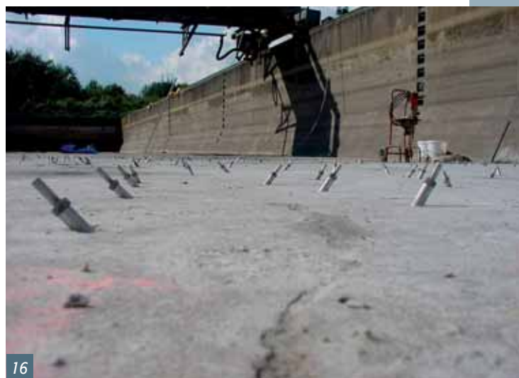
Obr. 15 Vodopropustné dělicí trhliny v podkladním betonu na ČOV (foto KST)
