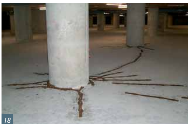
Obr. 18 Trhliny v podkladní betonové desce podzemních garáží
