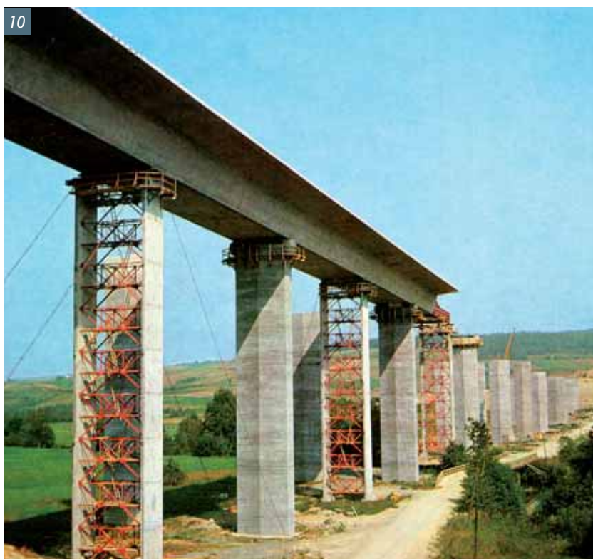
Obr. 13 Most přes Mohan u Gemünden (1985), pohled na přemostění řeky
