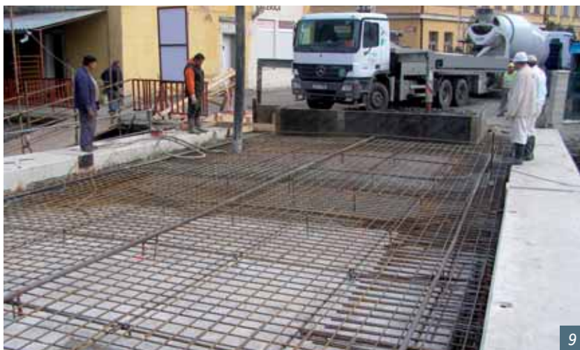
Obr. 7 Forma na panel zábradlí připravená k betonáži
