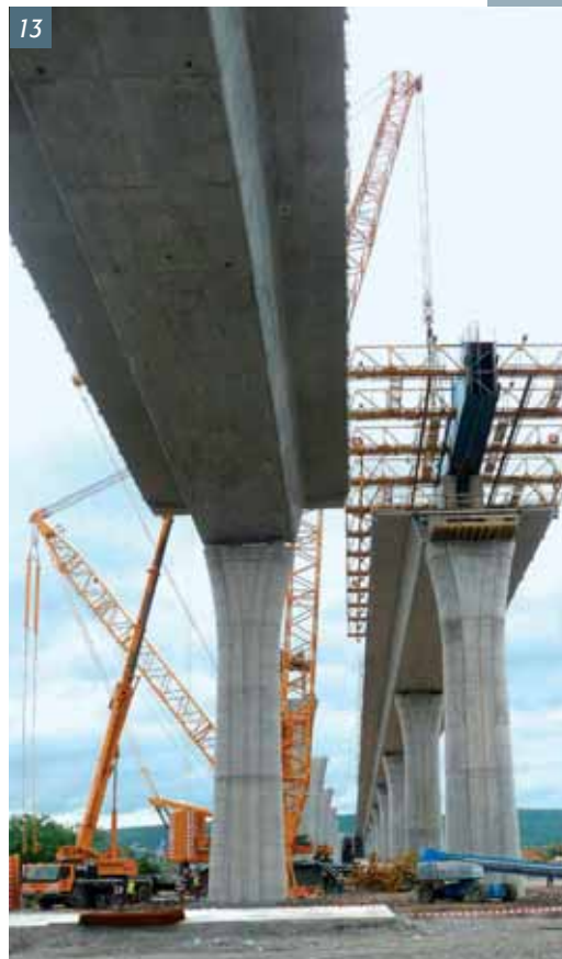
Obr. 13 Rozestavěný most SO 204/1.3, v pozadí jeden z největších jeřábů ve střední Evropě (nosnost 1 200 t) použitý pro otočení a přesunutí výsvuné skruže z levého na pravý most
