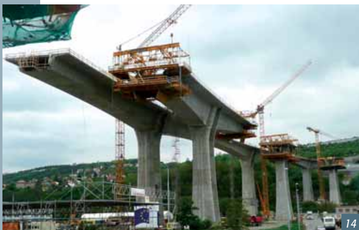
Obr. 14 Pohled na jednotlivá vahadla mostu SO 204/1.4
