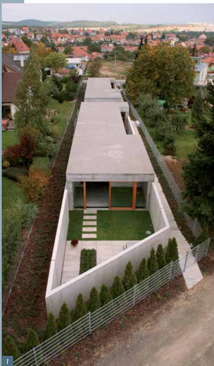
Obr. 1 Elastická stěrka Zentrifix F 92 použitá na střeše liaporbetonových domů v Brně navržených a realizovaných firmou Makovský & partneři, s. r. o.
