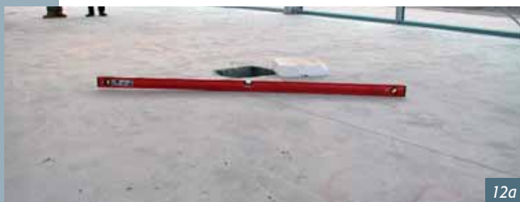
Obr. 12 Zkroucení desky betonové mazaniny a), b) Fig. 12 Curling of the concrete screed plate a), b)
