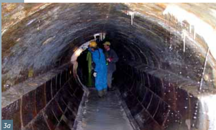
Obr. 3 Stoka před opravou s masivními průsaky a, b) Fig. 3 Sewer prior to the repair with massive seepage a), b)
