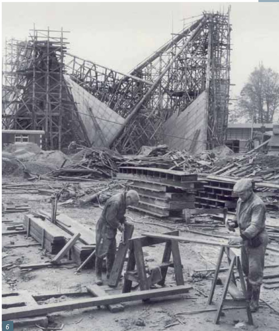
Obr. 6 Montáž pavilonu na ocelovém lešení
