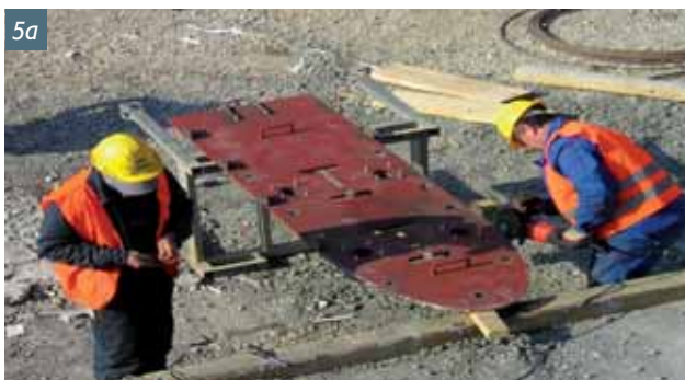
Obr. 5 a) Kotevní deska sloupu, b) botička na sloupu s předpínacími kabely, kotvami Halfen a kotvami pro přenos smykových sil
