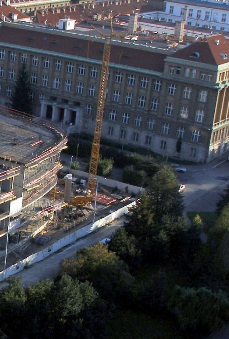
11 Celkový pohled na staveniště NTK | 12 Budoucí vstupní hala NTK
