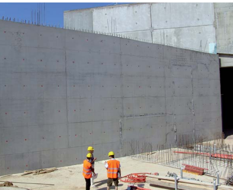
3 Rámové bednění Framax Xlife a jeho otisk | 4 Detail otisku rámu Framax Xlife | 5 Deska Framax Xlife | 6a Potažení rámového bednění TRIO Struktur bednicí deskou, b Výsledek z obr. 6a | 7a Nosníkové bednění VARIO, b Výsledný povrch z bednění VARIO, c Nosníkové bednění TOP 50
