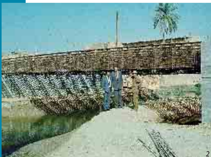
Obr. 3 Stavba mostu Jadiriyah přes Tigris v Bagdádu (délka 1281 m, šířka 32 m), Irák, 1981
