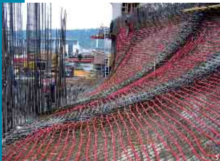
Obr. 5 Prostorová plocha bednění s osazenou betonářskou výztuží a rozvody pro sprinklery
