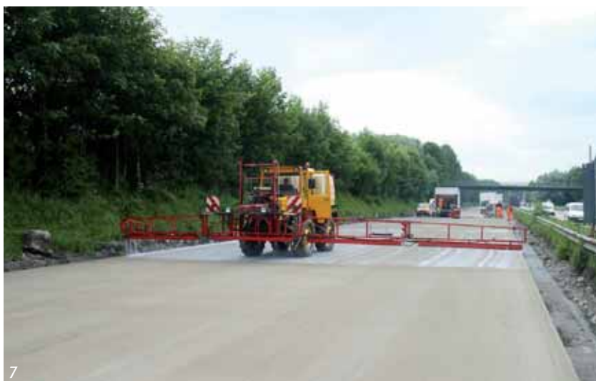
Obr. 7 Nadväzujúce ošetrovanie kefami upraveného povrchu vozovky nastriekaním bežného ošetrovacieho prostriedku z mobilného nosníkového zariadenia
