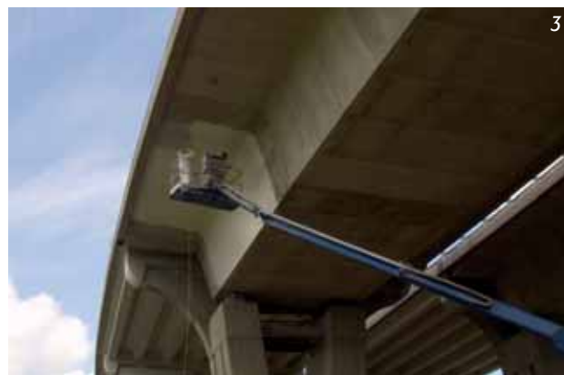
Obr. 3 Aplikace nástřiku sjednocujícího nátěru Masterseal® 368
