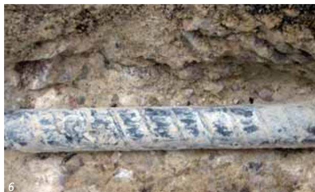
Obr. 6 Odhalená horní výztuž desky Fig. 6 Bared top reinforcement of deck slab
