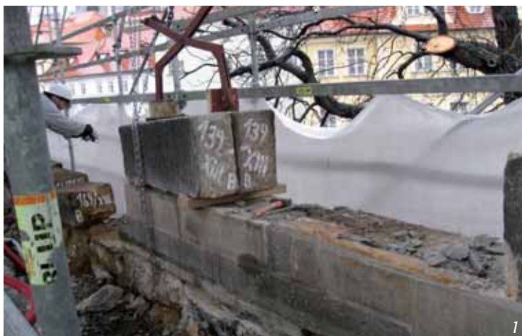
Obr. 1 Rozebírání kamenného parapetního zábradlí Fig. 1 The stripping of the stone parapet
