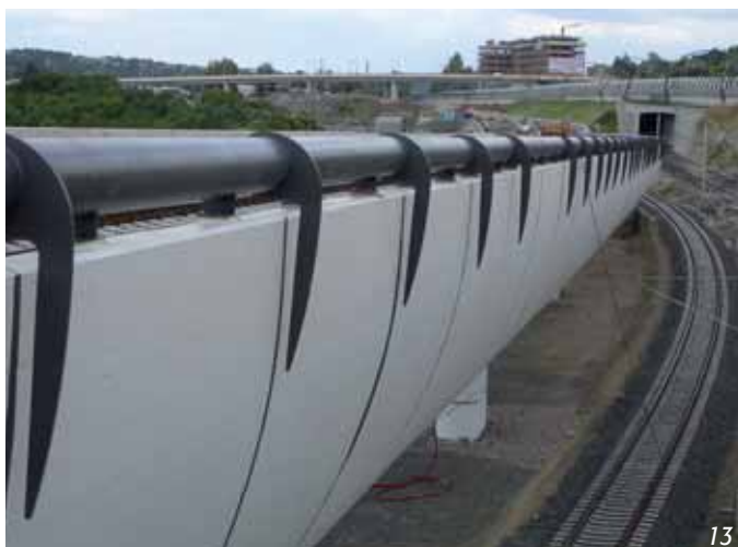
Obr. 13 Ocelové nosy zábradlí Fig. 13 Steel noses of the handrail
