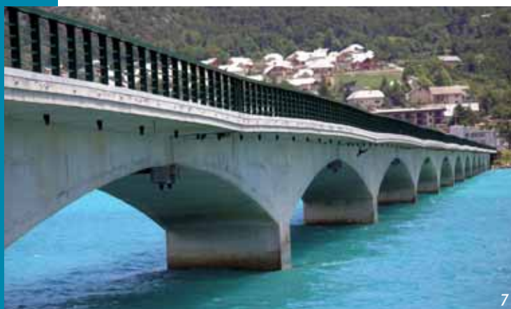
Obr. 7 Deformovaný most u Savines le Lac
