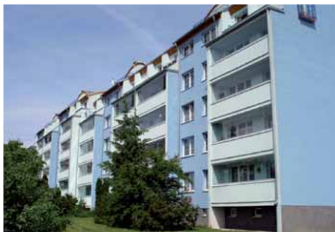
Obr. 1 Bytový panelový dům po rekonstrukci
