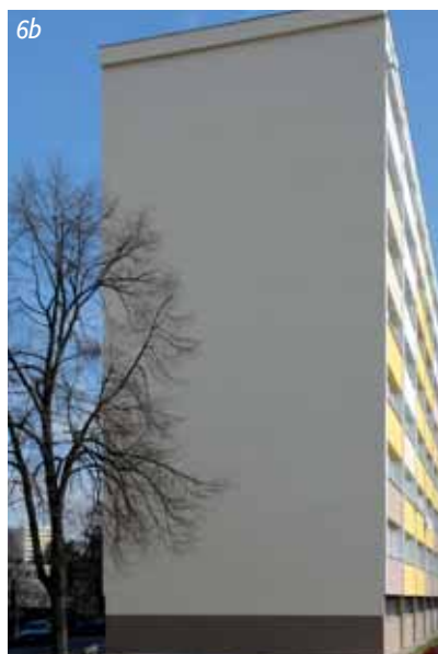
Obr. 6 Štítová stěna před odstraněním obkladních štítových panelů a po zateplení
