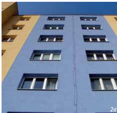
Obr. 2 Stav objektu dva roky po zateplení obvodového pláště: a) pohled na fasádu, b) detail balkonu s viditelným pokračováním koroze výztuže, vliv objemových změn korozních zplodin na soudržnost betonu, c) vyspádování oplechování balkonu s možností zatékání vody do konstrukce balkonu, d) důkaz, že trhlinky mezi panely obvodového pláště jsou živé – vykreslení trhlinek v nově provedené fasádě
