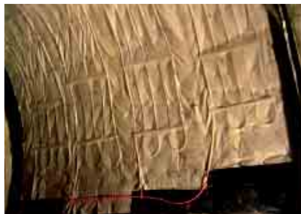
Obr. 2 a) získávání energie v Lainzer tunelu, b) absorpční rohož mezi ostěními raženého tunelu (Expertenforum Beton 2006, Klimadesign – Heizen und Kühlen mit Beton)
