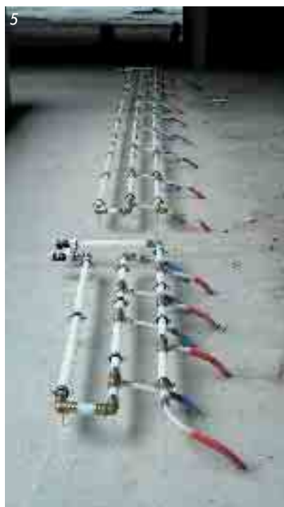
Obr. 5 Rozdělovač a sběrač jednotlivých okruhů TABS umístěný ve zdvojené podlaze
