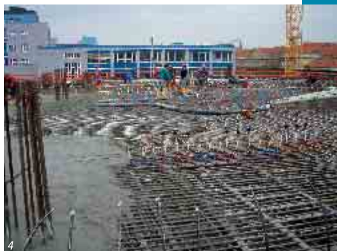
Obr. 1 Stropní konstrukce s armováním, předpínacími kabely a potrubím systému TABS
