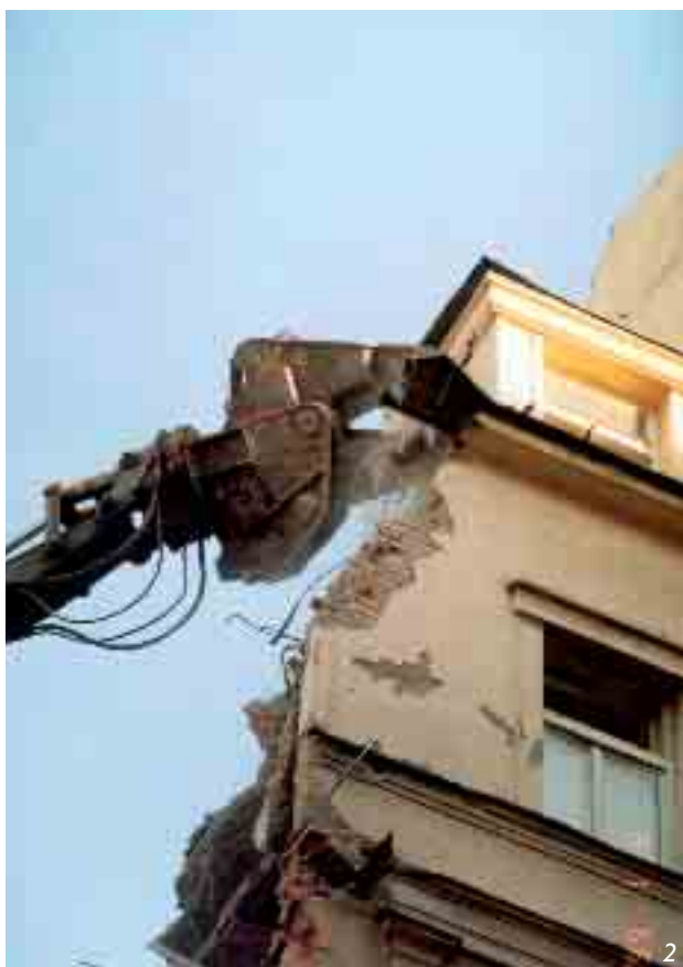
Obr. 2 Postupná demolice stavební konstrukce
