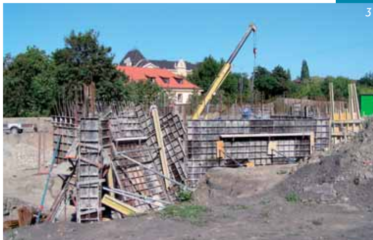
Obr. 3 Prvkové bednění spodní části stěny Fig. 3 Panel formwork of the bottom part of the wall
