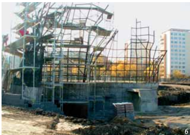
Obr. 6 Ocelová konstrukce horní části stěny Fig. 6 Steel structure of the the upper part of the wall
