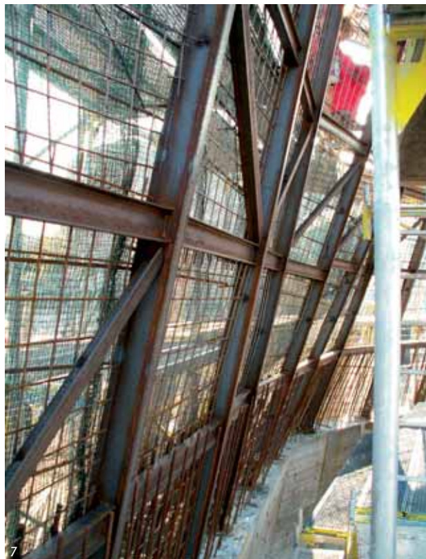
Obr. 8 Lešení pro torkretování Fig. 8 Platform for concrete lining
