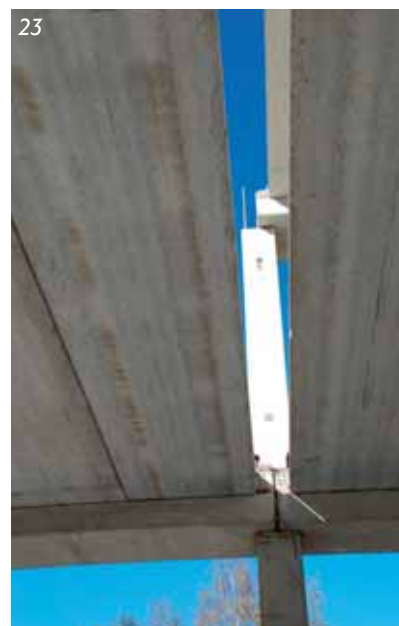
Obr. 22 Detail ztužujícího trigonu; 1 – trigony, 2 – dobetonávka, 3 – panely Partek, 4 – průvlaky, 5 – sloupy
