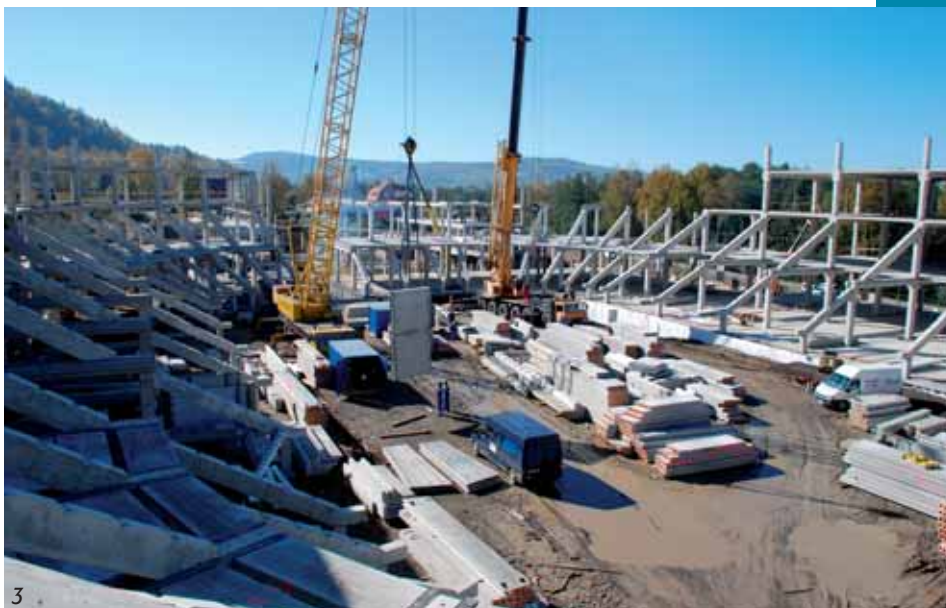
Obr. 3 Montáž prefabrikované konstrukce – celkový pohled
