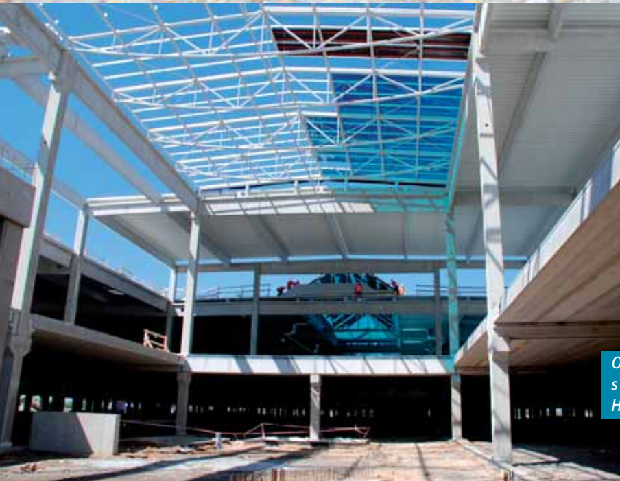
Privátní chirurgické centrum SANUS v Hradci Králové, prefabrikované konstrukce s filigránovými stropními deskami (PREMO)
