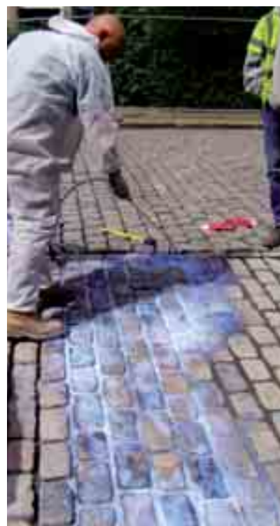
Obr. 2 Bodová injektáž malty a aplikace urychlovače tuhnutí
