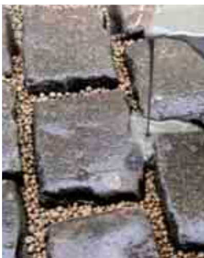
Obr. 1 Řídká malta litá mezi granulované slinuté kamenivo z popílku
