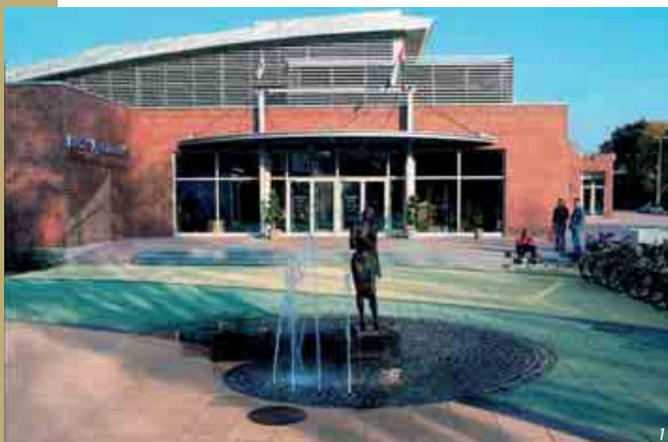
Obr. 1 Velkoformátová dlažba Corona Brillant v odstínech alpská zelená, dunajská pestrá, obilná žlutá a korallo růžová u Městské sportovní haly v Maďarsku
