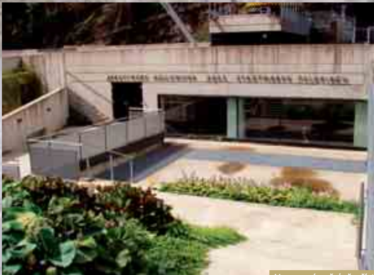
Upravený veřejně přístupný prostor na hrázi přehrady na řece Ill ve Feldkirchu, Švýcarsko - „vodní“ schody pro lososy přes přehradu - okno pro sledování lososů
