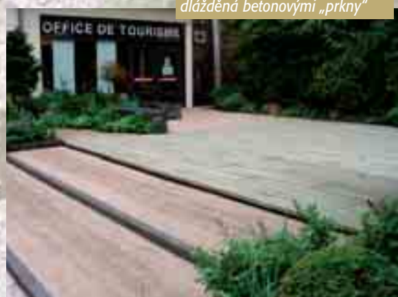
Plošina před turistickou kanceláří v Angeru, Francie, dlážděná betonovými „prkny“
