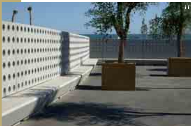
Obr. 11 Murllum, jednoduché panely s rastrovými kulatými otvory vyplněnými masivním zezadu prosvíceným sklem Fig. 11 Murllum, simple panels with a raster of circular holes filled with massive glass transilluminated from behind
