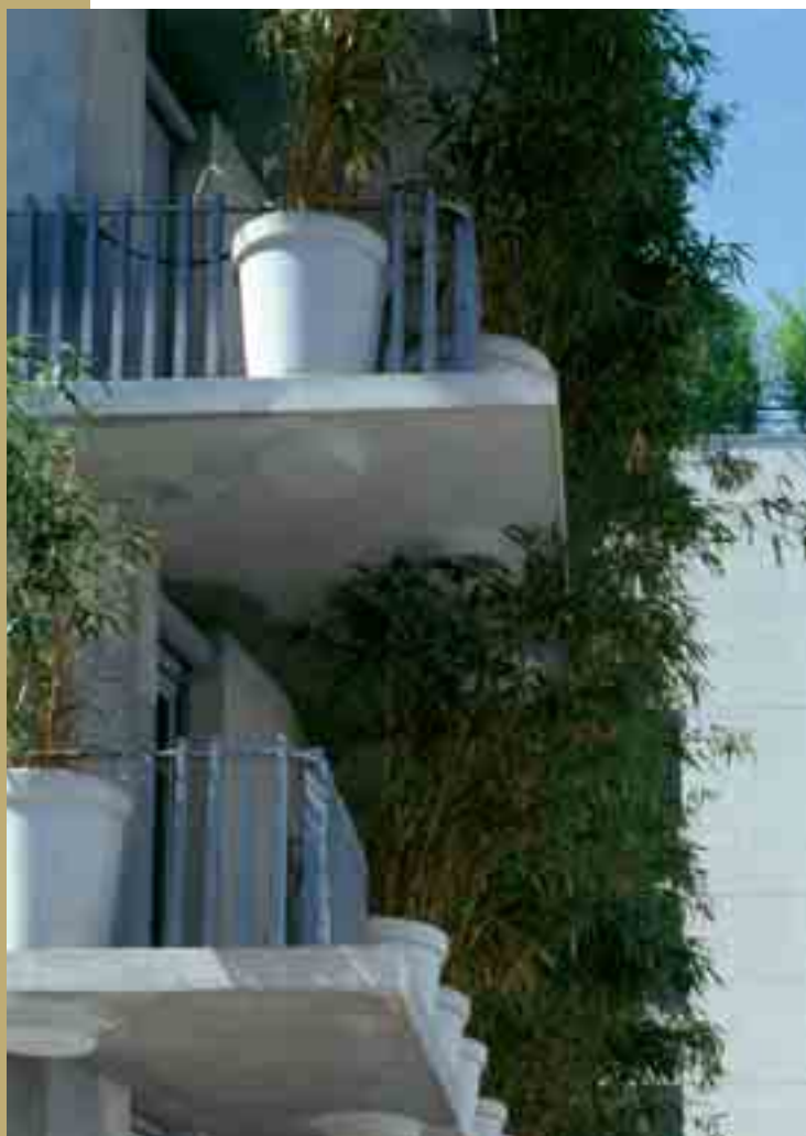
Obr. 2 Detail fasády se střídáním dvou odstínů betonu
