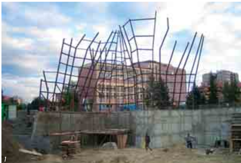
Obr. 1 Ocelová nosná konstrukce Fig. 1 Steel carrying structure
