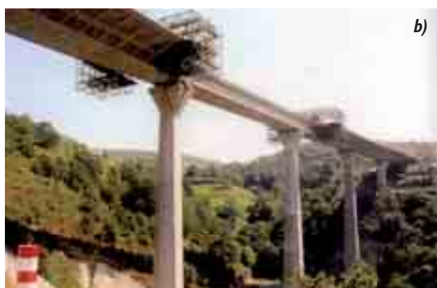
Obr. 9 a) Mosty Piedrafita – montáž segmentů, b) betonáž konzol, c) hlavy pilířů a výsledný podhled nosné konstrukce
