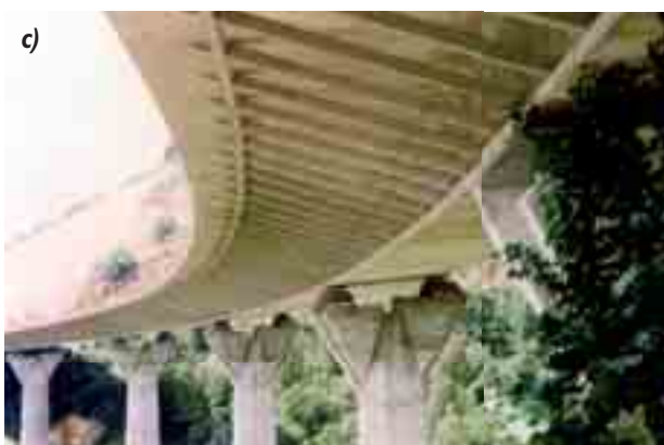
Obr. 9 a) Mosty Piedrafita – montáž segmentů, b) betonáž konzol, c) hlavy pilířů a výsledný podhled nosné konstrukce
