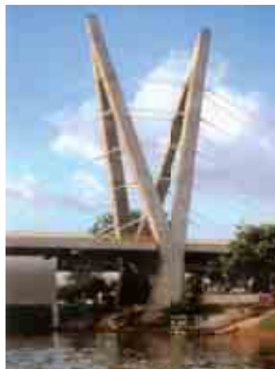
Obr. 4 a) Most Villahermosa, b) prostorový pylon
