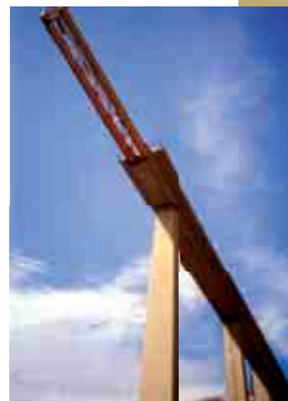
Obr. 10 a) Most Atenquique, b) nosná konstrukce při výsuvu
