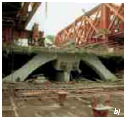
Obr. 3 a) Most Pontevedra, b) letmá betonáž mostovkové konstrukce, c) první návrh konstrukčního řešení mostu, d) statické scéma mostu
