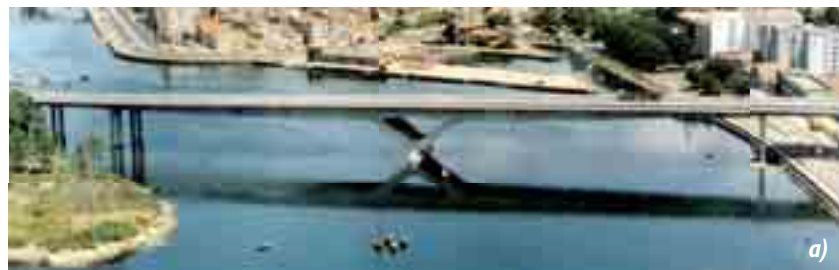
Obr. 8 a) Most Puente deume přes řeku Arosa, b) pilíř s přikotveným zárodkem a start letmé betonáže
