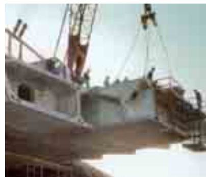
Obr. 2 a) Most Sancho el Mayor, b) montáž mostovkové konstrukce
