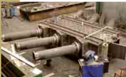
Obr. 6 Výztuž paty pylonu
