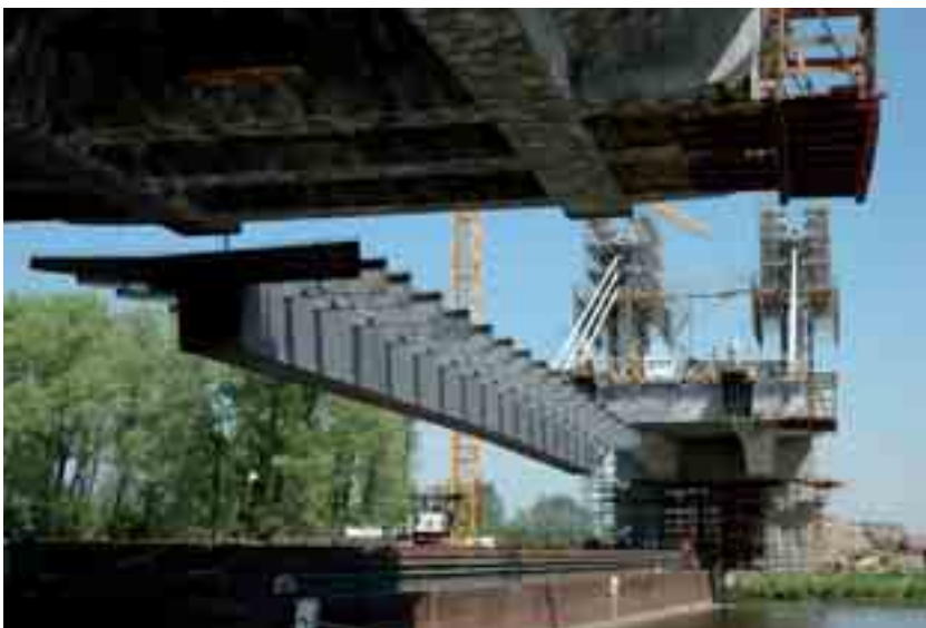
Obr. 10 Montáž ocelové části hlavního pole Fig. 10 Erection of the steel girders
