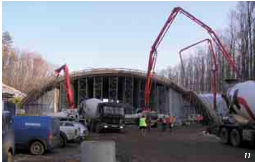
Obr. 11 Betonáž oblouku v zimním období, zateplení skruže
