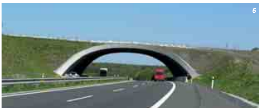
Obr. 6 Pohled na zelený most směr Hradec Králové, stavba 1104-1, SO A234
