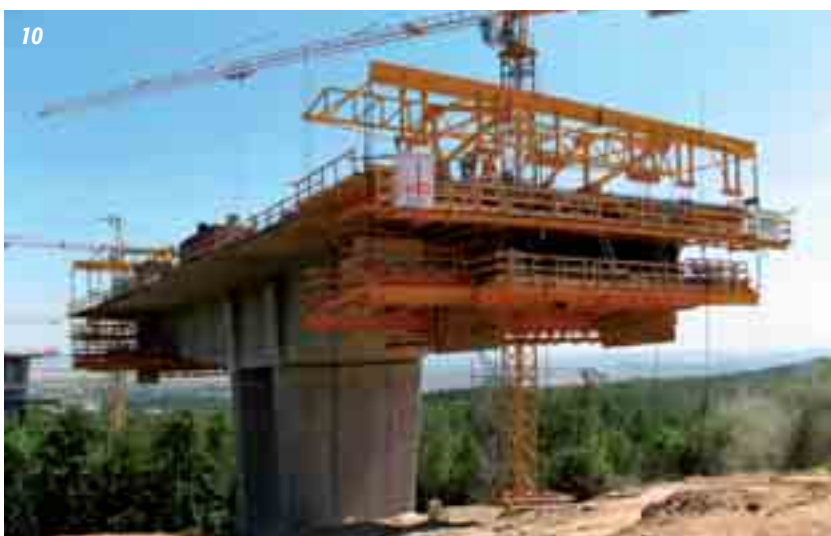
Obr. 7 Zárodek CD během výstavby Fig. 7 Hammerhead CD under construction
