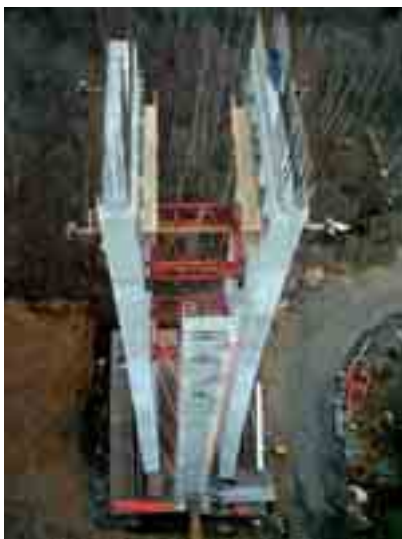
Obr. 4 Pilíř P3 po dokončení Fig. 4 Pier P3 after completion
