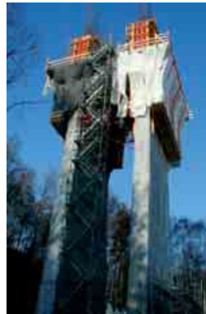
Obr. 14 Šplhací bednění ACS od firmy PERI Fig. 14 ACS climbing formwork from PERI
