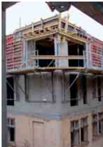
Obr. 11 Bednění nástavby dvorních křídel Fig. 11 Formwork of yards bays bulkhead
