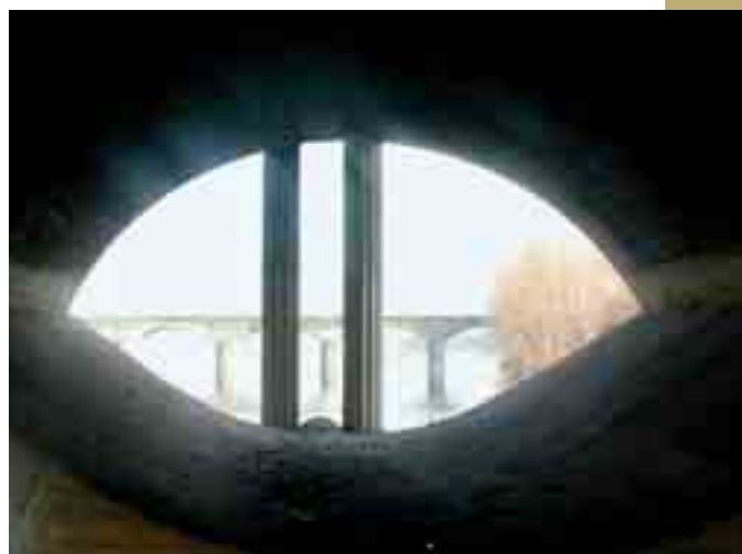
Obr. 6 Odlehčovací klenba mostu Fig. 6 Lightening of the bridge vault
