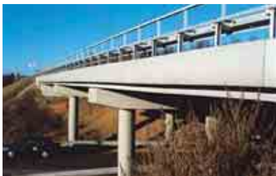
Obr. 1 Most na silnici I/35 u Jeřmanic
