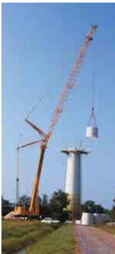
Obr. 3 Pracovní plošina se spojovacími můstky tvoří bezpečnou a tuhou konstrukci, ze které je řízeno osazování těžkých betonových prefabrikátů
