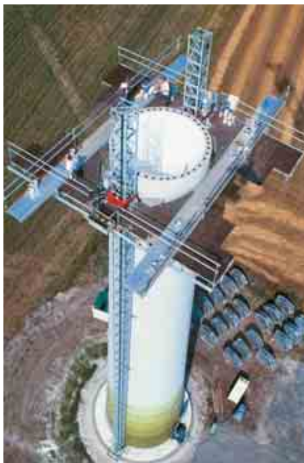
Obr. 3 Pracovní plošina se spojovacími můstky tvoří bezpečnou a tuhou konstrukci, ze které je řízeno osazování těžkých betonových prefabrikátů
