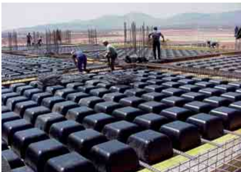
Obr. 7 Kazetové bednění z plastových kopulí Uninox
