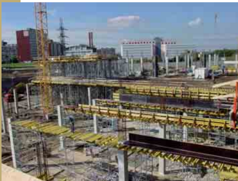
Obr. 9 Pohled na rozestavěnou konstrukci Fig. 9 View of the unfinished object structure
