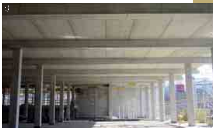
Obr. 4 Charakteristické konstrukce pro rozpon 16,2 \times 8,1 \text{ m} a) schéma b, c) realita
