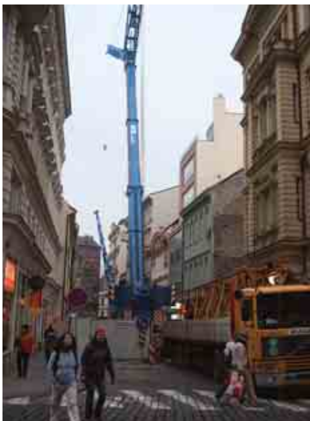
Obr. 1 Montáž jeřábu Fig. 1 Assembly of the crane
