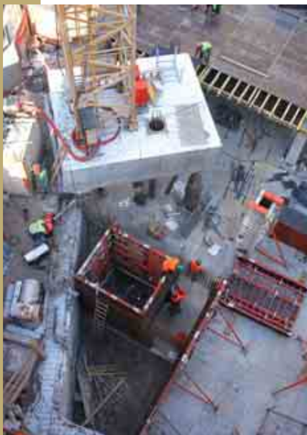
Obr. 4 Základ jeřábu – pohled shora Fig. 4 Crane foundation – view from above
