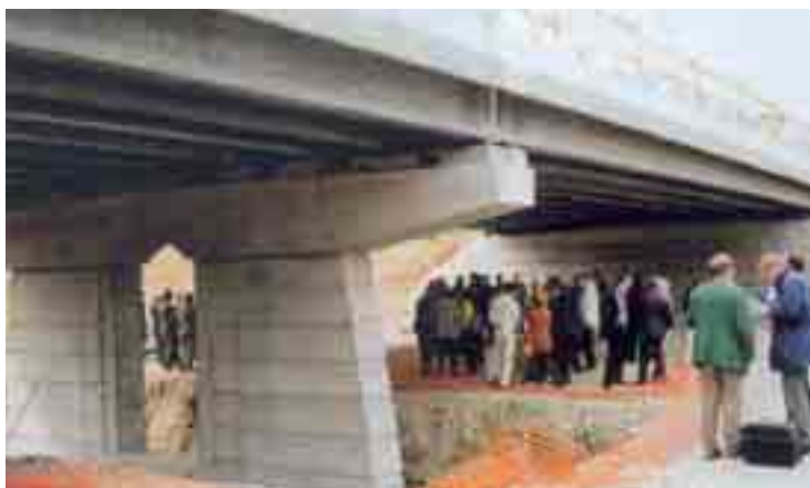
Obr. 6 Viadukt Bourg-les-Valences, betonové trávce pevnostní třídy C200 Fig. 6 Viaduct Bourg-les-Valences, concrete beams in strength class C200
