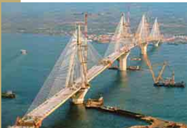
Obr. 3 Most Rion Antirion během stavby, návrh založený na nelineárním časovém průběhu dynamické odezvy
