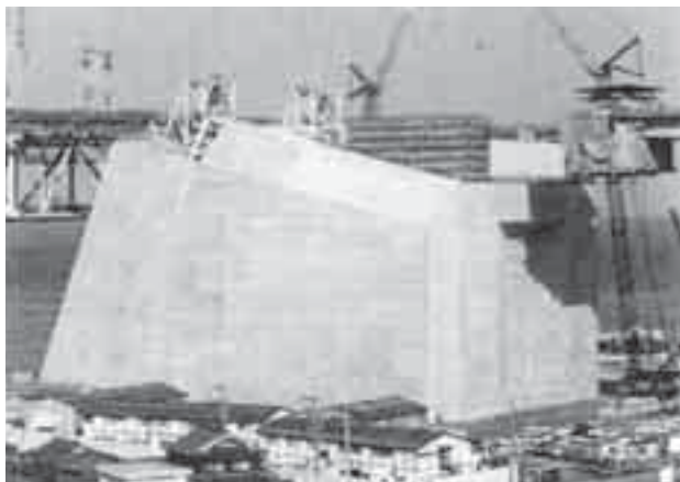
Obr. 31 Kotevní blok 4A mostu Akashi-Kaikyo Fig. 31 Anchorage 4A of Akashi-Kaikyo bridge
