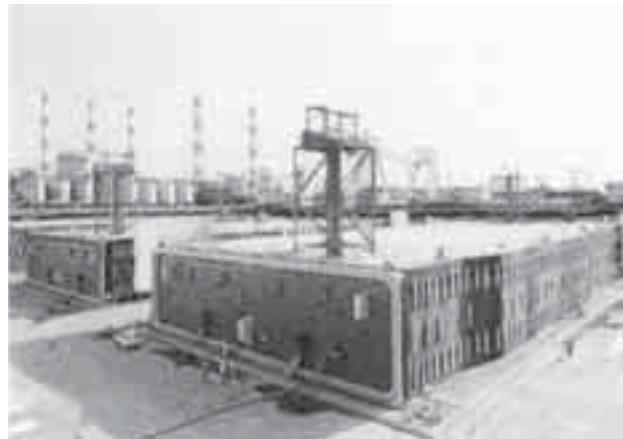
Obr. 35 Sendvičová konstrukce ponořeného tunelu
