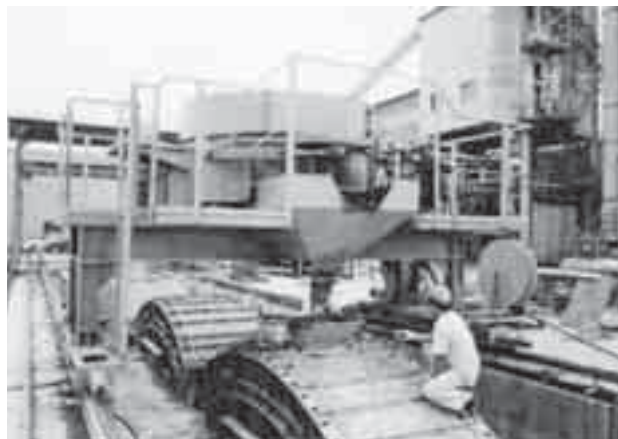
Obr. 32 Ukládání SCC na segmentu tunelu Fig. 32 Casting of SCC for tunnel segment
