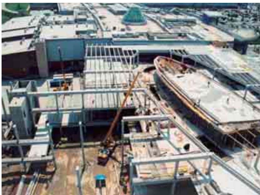
Obr. 1 Celkový pohled na rozestavěnou konstrukci
