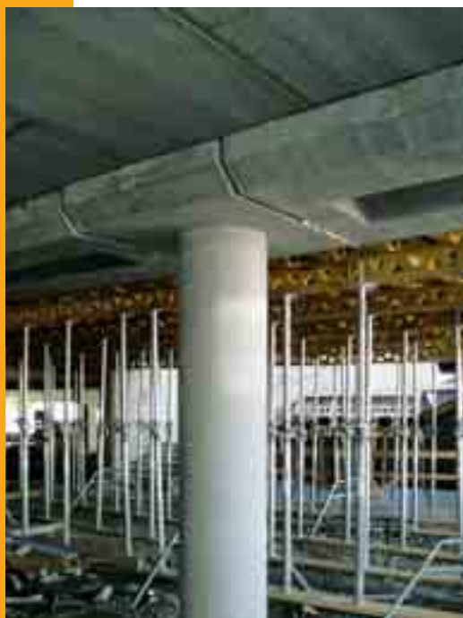
Obr. 14 Krajní nosník na rozpon 15,6 m s návazností na stávající objekt Fig. 14 Outside beam for the span of 15.6 m adjacent to the existing building
