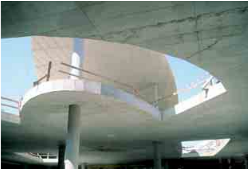
Obr. 18 Komplikované průhledy monolitickou stropní konstrukcí
