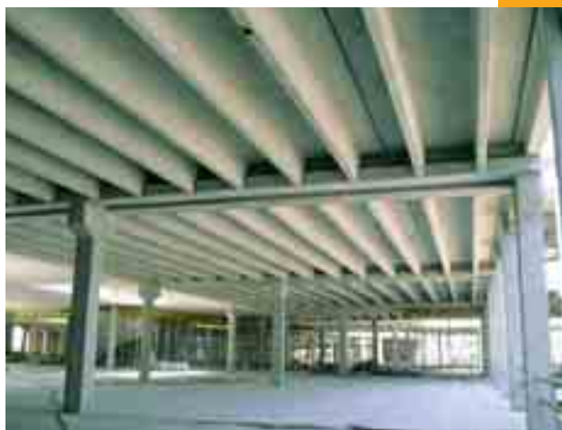
Obr. 6 Strop s žebrovými panely Fig. 6 Ceiling with ribbed panels
