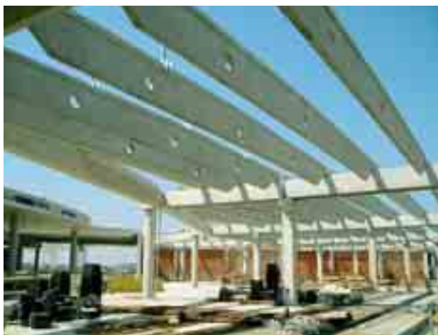
Obr. 8 Střešní konstrukce s vaznicemi Fig. 8 Floor structure with the purlins
