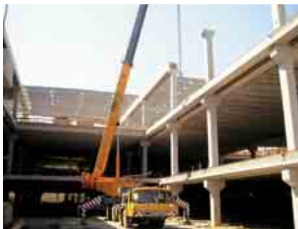
Obr. 4 Souběžná montáž stropů a střešní konstrukce Fig. 4 Simultaneous assembly of ceilings and the roof structure
